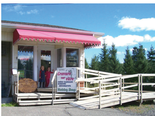
Afin de subvenir à notre clientèle de boutique, une rampe d'accès a été ajoutée au perron déjà existant. C'était le seul endroit du site qui n'avait pas reçu cette accommodation.
